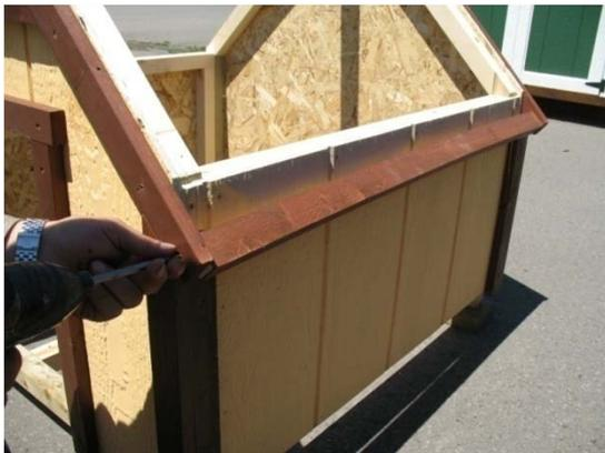
左右の軒先に、「軒先棒」を取り付けます。印にあわせて、「軒先コースビス65mm」を4本使い、固定します。
